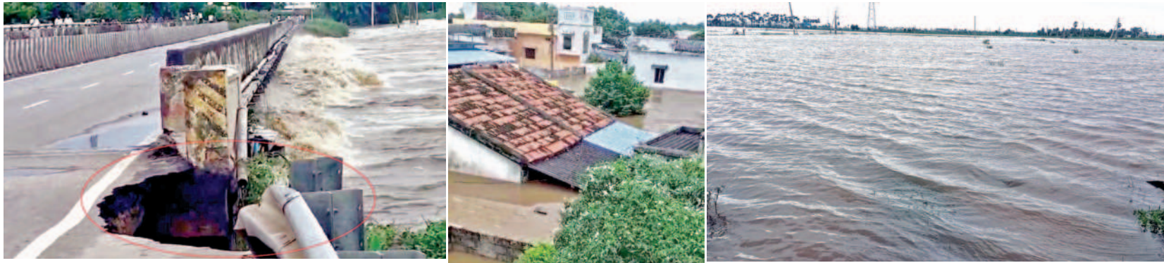
ఆంధ్రా-తెలంగాణ రాష్ట్రాలను కలుపుతున్న గరికపాడు పాలేటి బ్రిడ్జిని తాకి రహదారిపై పడిన ప్రమాదకర గండి. ముంపున కు గురైన జగ్గయ్యపేట మండలం బూదవాడ గ్రామం. వరద ముంపునకు గురైన పంటపొలాలు.
